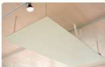
Abb. Deckenmontage in einem Pavillon
