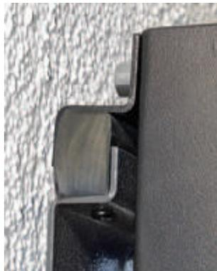
Gummigelagerte Schwingungsdämpfer vermeiden eine Schallübertragung auf das Mauerwerk und darüberliegende Wohnräume.
